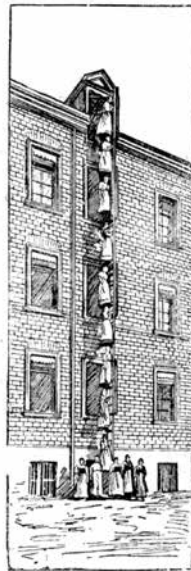
Scherrerova záchranná okna otevřená. Řebřík jest úplně zatížen.
