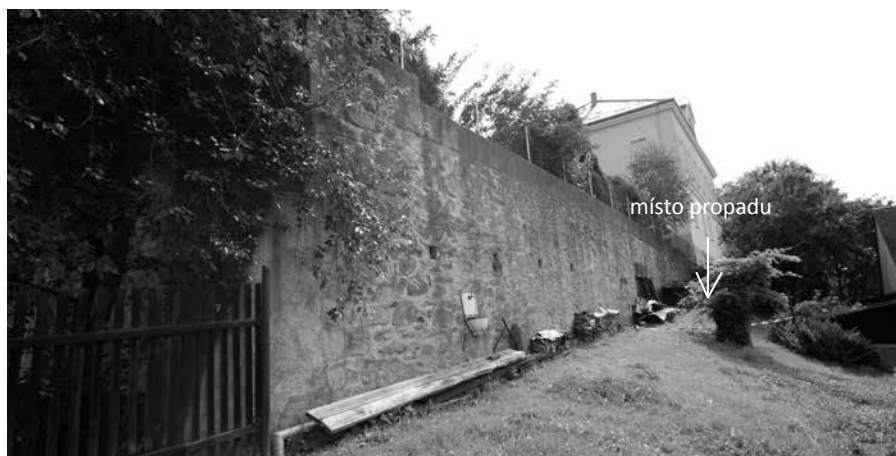
Jižní část zahrady p. p. č. 40 s částečně dochovanou renesanční ohradní zdi někdejšího tvrziště, pohled od SV (foto L. Rypka)
